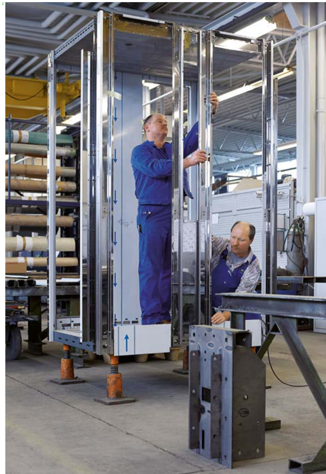
2 Montáž skleněné panoramatické kabiny
