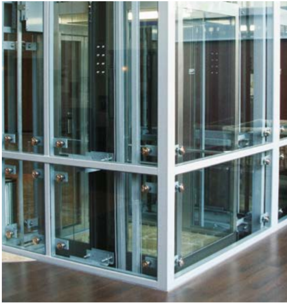
Trubková konstrukce šachty, čtvercové jeklové profily Upevnění skla – bodové zasklení, Zasklení mezi profily
