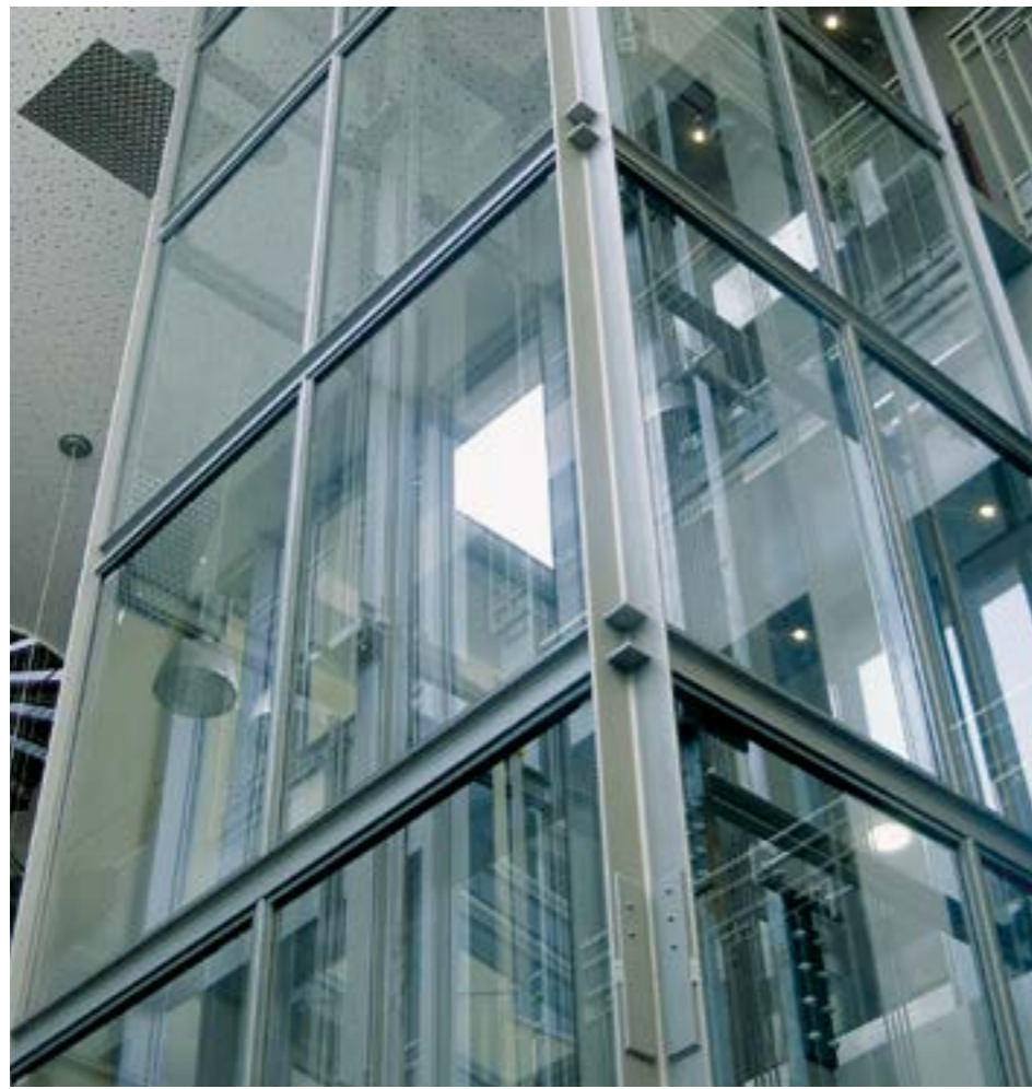
Úhelníková konstrukce šachty Úhel otevřen ven
