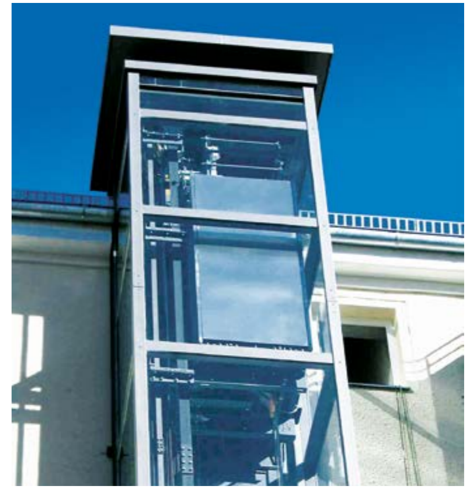
Úhelníková konstrukce šachty Úhel otevřen dovnitř
