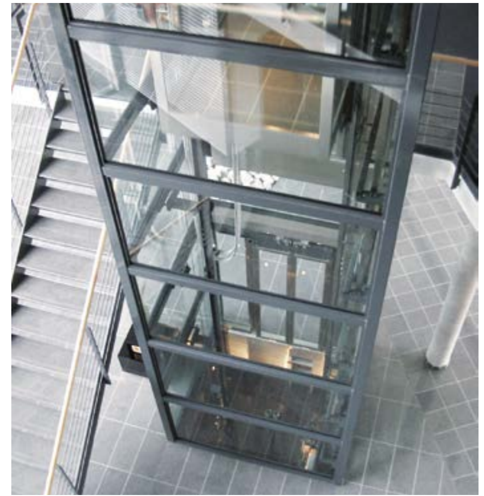
Trubková konstrukce šachty, čtvercové jeklové profily Zasklení mezi profily
